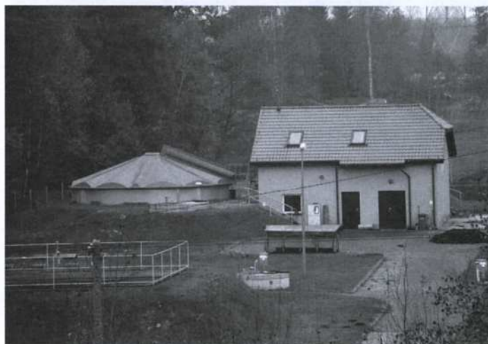
Rozbudowana oczyszczalnia ścieków w Lipcach Reymontowskich
